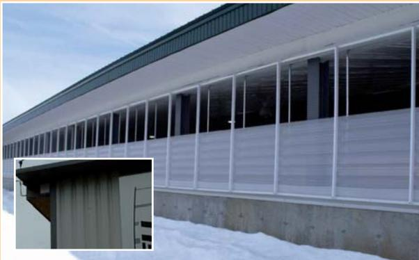
Diese isolierende Barriere der Multiwand minimiert die Wärmeübertragung zwischen der kalten Außenluft und den warmen Innenluftzellen.
