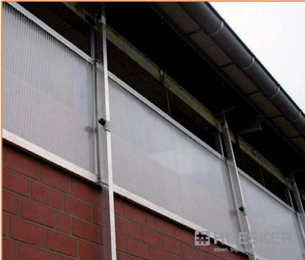
perfekte Zuluftregulierung durch das einzigartige Verschuß- und Dichtsystem
