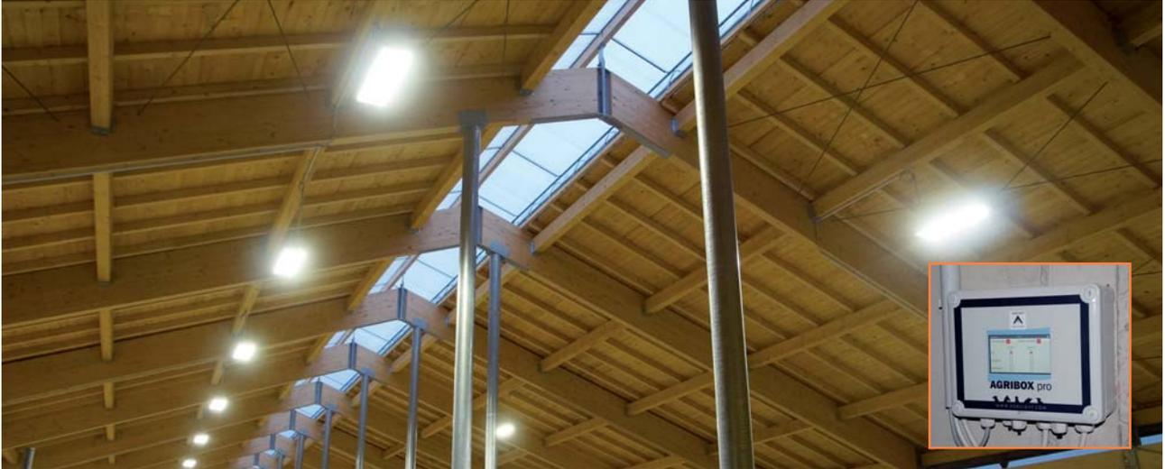
Vollautomatisches Lichtprogramm für mehrere verschiedene Lichtstränge mit automatischer Lichtstärkenerkennung
