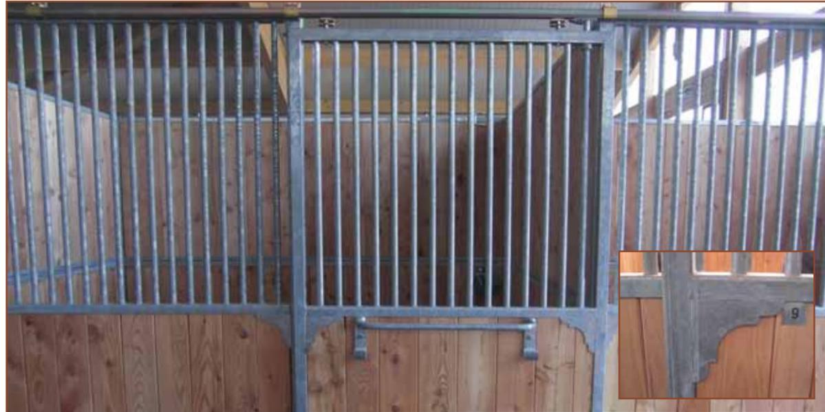
Formschön und funktionell - die in den Ecken eingebauten Knotenbleche geben den Boxen zusätzlich Stabilität. Der Deckenhalter an der Tür sorgt für eine stets übersichtliche Stallgasse.
