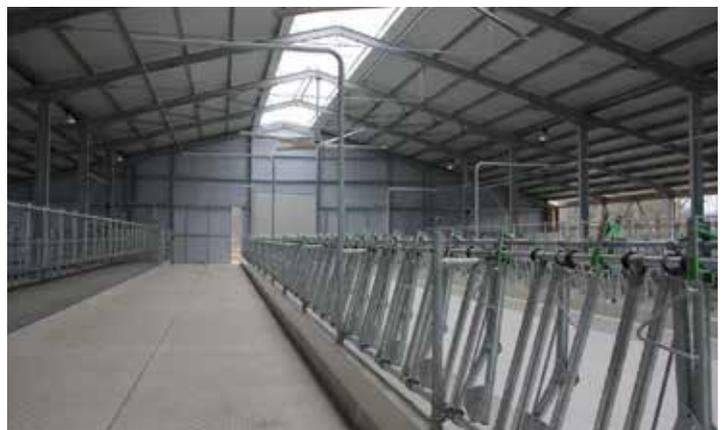
auf 2” Steher mit Schrägstellung, wahlweise mit integrierter Halterung für die Stallkühlung
