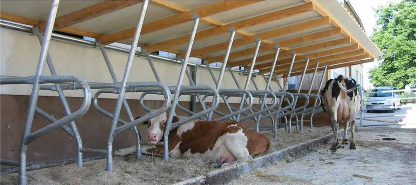
**CUCCETTENBOXEN** – kostengünstige, einfache Bauweise, Ausführung als Pilzrahmen 2“ mit Dachstützen
