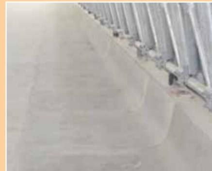
säurefeste und hochverschleissfeste Futterbarnschale aus Polymerbeton mit glatter Oberfläche, gewährleistet bestmögliche Futteraufnahme
