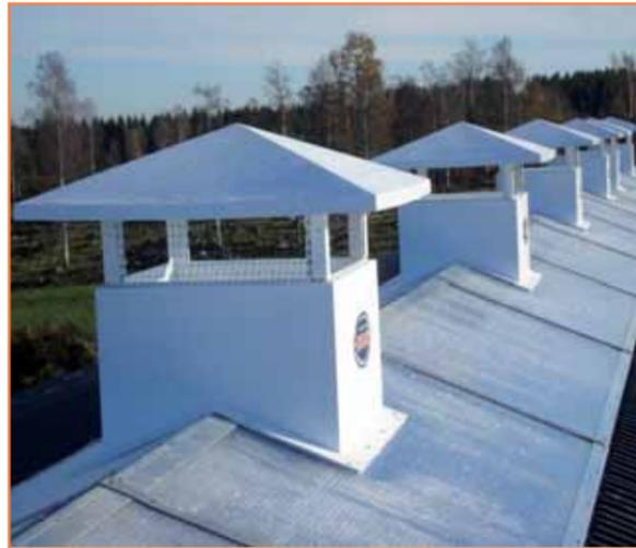
Abluftkamin mit Vogelschutzgitter und mechanischen oder vollautomatischen Abluftklappen - Lichtfirstfläche wird an Stallgröße individuell angepasst
