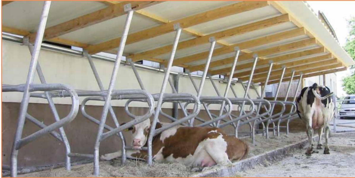
CUCCETTENBOXEN - kostengünstige, einfache Bauweise, Ausführung als Pilzrahmen 2" mit Dachstützen
