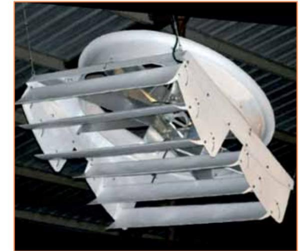
Der Deckenventilator sorgt auch bei geringen Stalldeckenhöhen für sehr gute Frisch- und Umluft.
