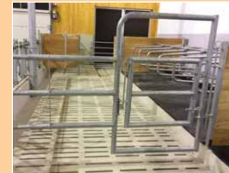
Tele 3 mit Viehdurchtrieb und Schnellverschluss
