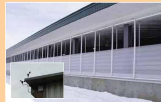
Diese isolierende Barriere der Multiwand minimiert die Wärmeübertragung zwischen der kalten Außenluft und den warmen Innenluftzellen.
