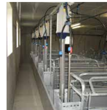
Bediengang mit Unterflurzuluft
