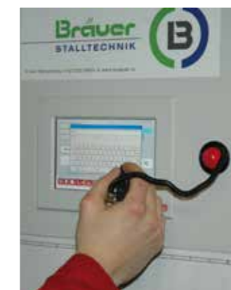
Touchbedienung direkt am Schaltschrank
