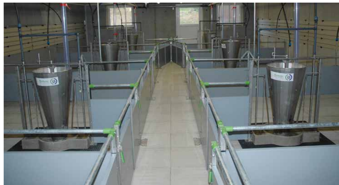
Twinrohrheizung an der Wand – Zuluft von oben
