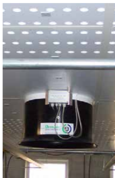
ZULUFTDECKE 25 mm isoliert, mit Deckenheizung und Abluftregelklappe
