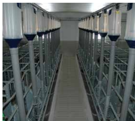
Nasenlüftung durch Unterflurzuluft
